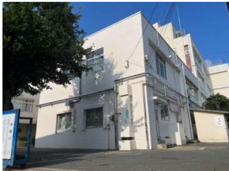
▲本校正門から（8月24日撮影）。塗装が劣化していた外壁2面がきれいに塗り直されました。
